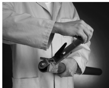
Снятие фаски с торцов труб
